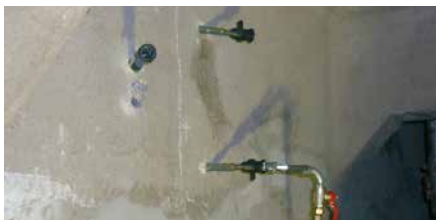
Stahlpacker mit Verschlussstück Steel packer with shutt-off piece
