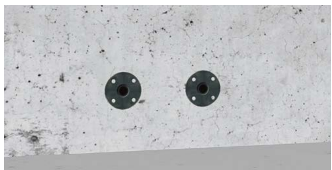
② Nagelpacker nach Entfernen der Schalung ② Nail packers after removal of framework
