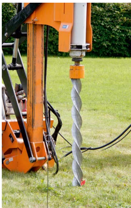
Einrammen der Gewindepfähle Pile-driving
