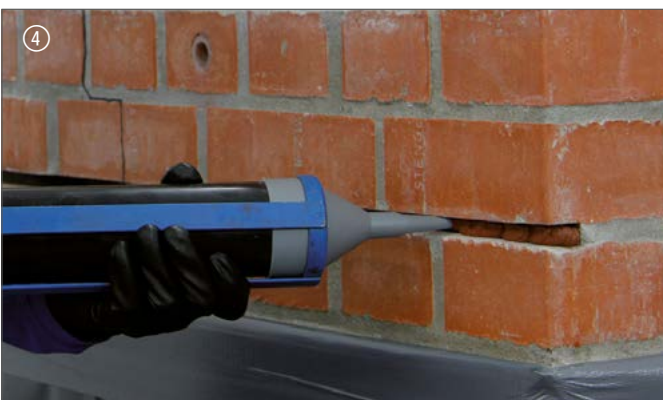
4 Erste Lage DESOI Spiralanker einbringen | Insert first layer of DESOI spiral anchor
