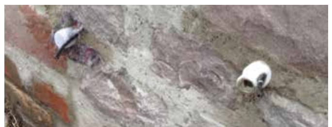
Verfüllpacker mit Entlüftungsschlauch, für Anschluss Schnellschnappverschluss | Shut-off piece with venting hose, for connection quick snap
