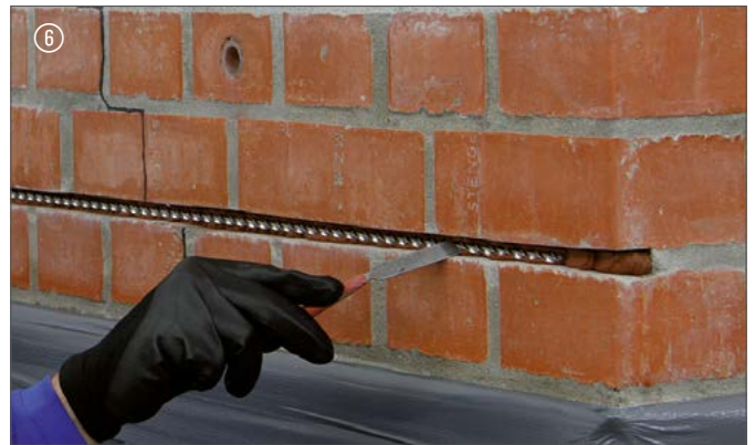
6 DESOI Spiralanker in den Mörtel drücken | Embed the DESOI Spiral Anchor Mortar
