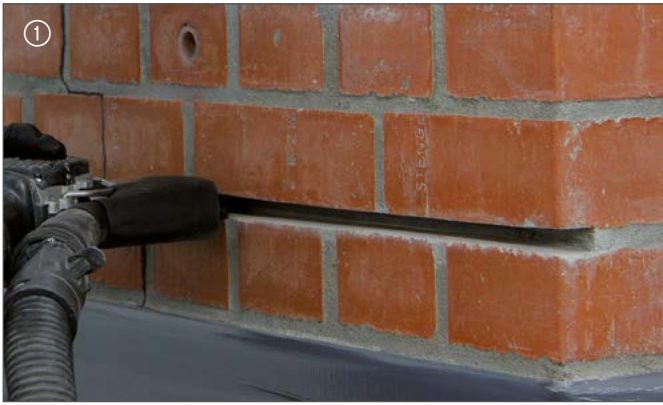
1 Fuge mit AS170 Stein- und Fugensäge aussägen | Cut the joint/slot by using the AS0170 Brick and mortar saw
