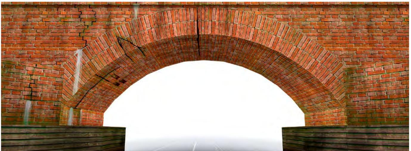
Risse im homogenen Mauerwerk - Sanierung mit mineralischen Füllstoffen | Cracks in homogeneous masonry - restoration with mineral filling materials
