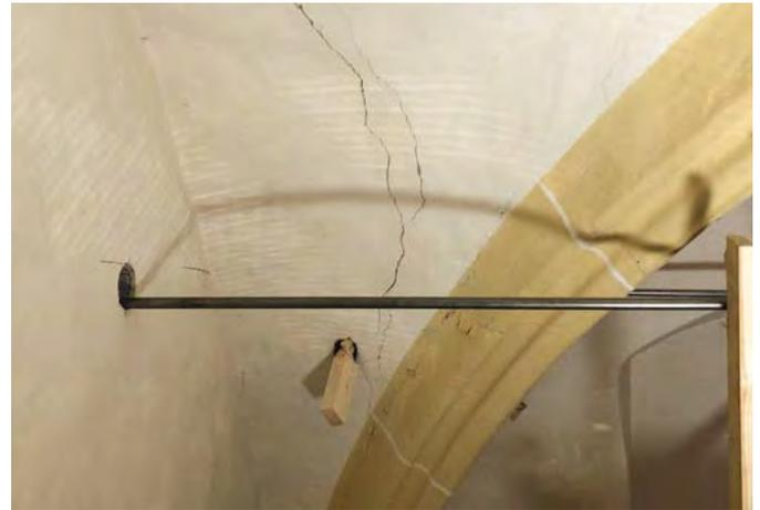
Risse im Gewölbe | Cracks in the vault
