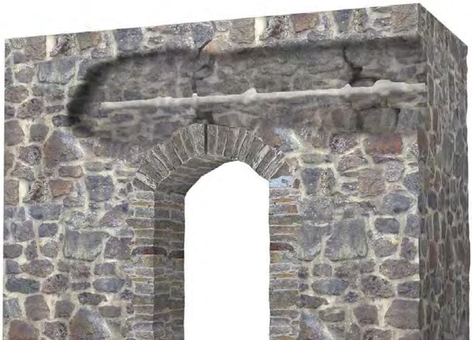
Sicherung gerissener Bauteile | Securing of cracked structural elements
