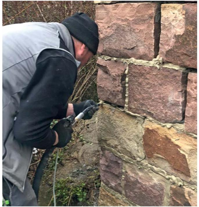
**7.7.4** Verfügen von Mauerwerksfugen: Zubehör - Schlauchpumpe
