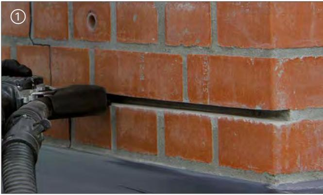
Fuge mit AS200X Stein- und Fugensäge aussägen
