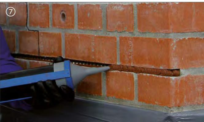
Zweite Lage DESOI Spiralankermörtel einbringen
