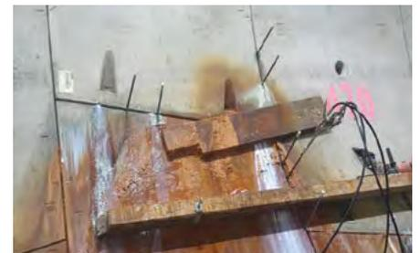
**Abdichtung von undichten Bewegungsfugen**
